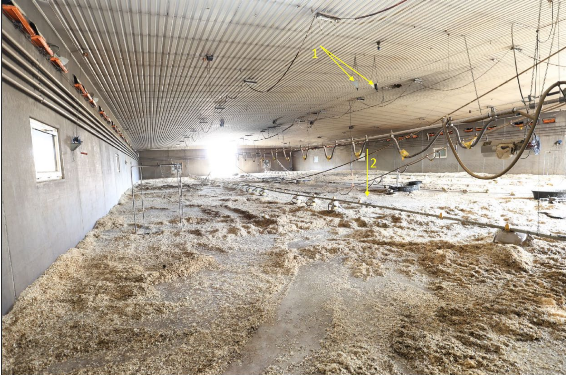
Fig. 11: Viser dyrerommet sett fra motsatt ende, jf. fig. 10. Pilene 1 viser til kjettinger/festeanordning for sirkulasjonsvifta E-1. Pil 2 viser posisjon for vifta E-1 på gulvet.
